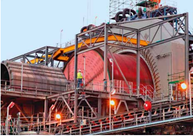
Steinmühle in Südafrika mit großen Lagern, die über eine Zentralschmieranlage bedient werden. Das Ölvolumen wird gemessen mit VHS-Geräten von GHM.
